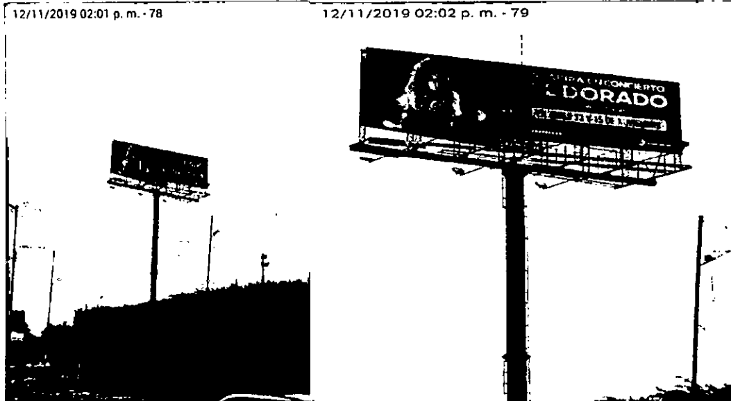
Foto No.1 y 2: Vista panorámica del predio, del panel y de la estructura de la valla, ubicada en la Av. Carrera 45 No. 153-81 (dirección catastral), orientación Norte-Sur.
